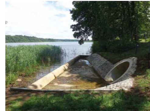
Rechtzeitig vor der Brutsaison konnten wir die neue Anlage zur Hochwasserentlastung fertigstellen.
